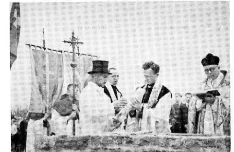
Schließung der Rolle, die in den Grundstein eingemauert wird, durch Kaplan Kayser und Maurer Wilhelm Weber aus Spurkenbach.
